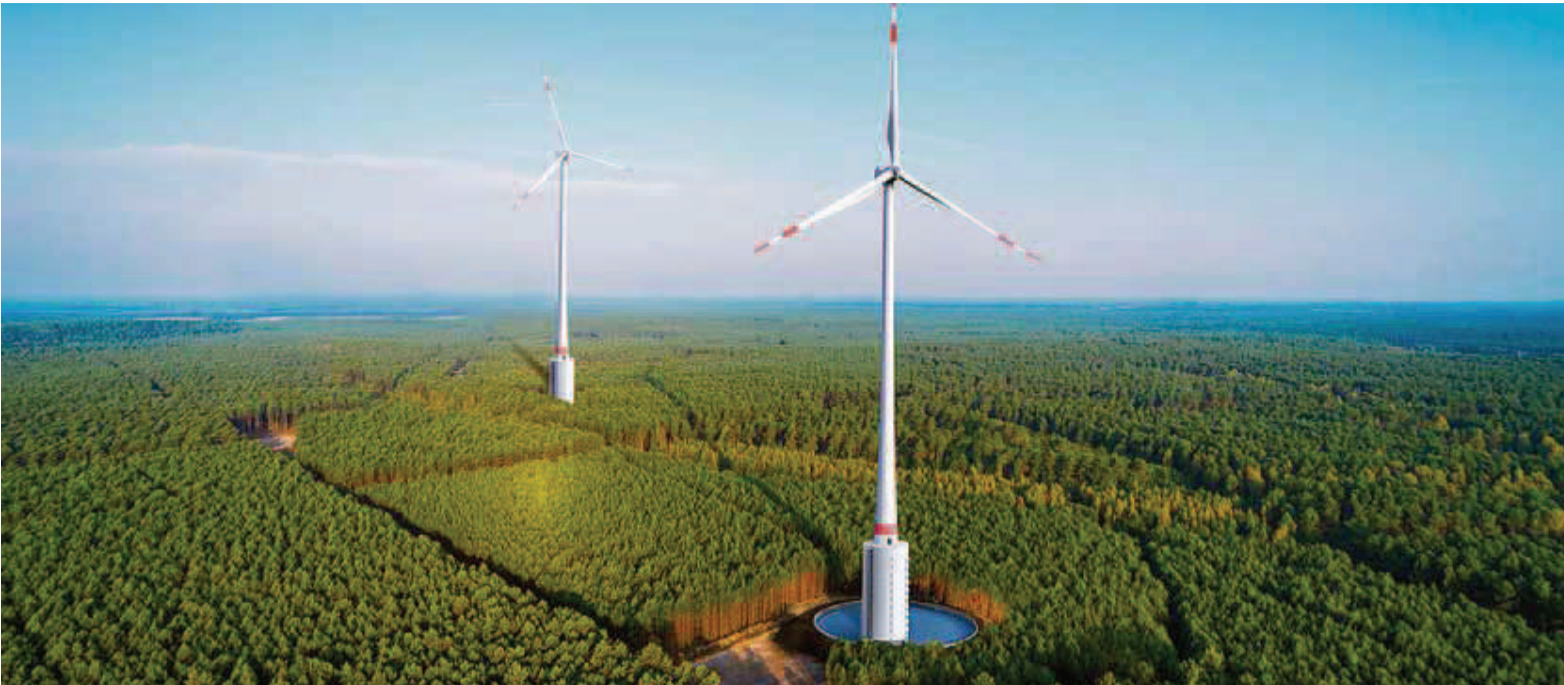
Die höchsten Windräder der Welt werden ab Oktober in Gaildorf stehen – mit dem Max Bögl-Hybridturmsystem und Wasserspeicher im Turmfundament.
